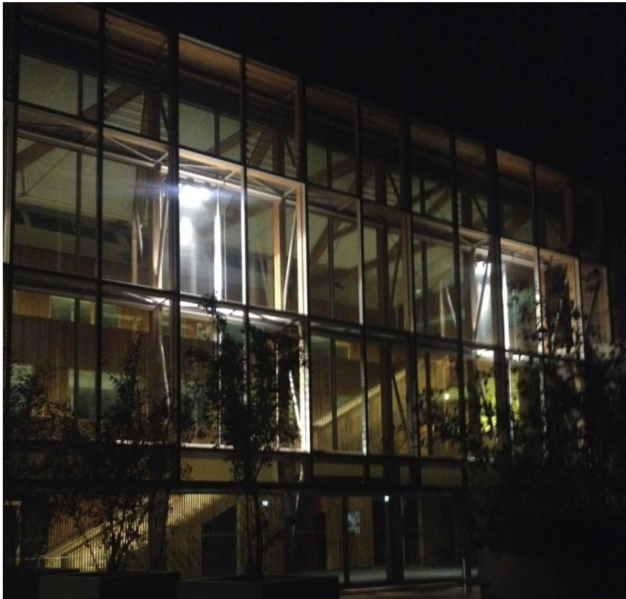
Figura 6 Vista externa do edifício em Aurillac.
