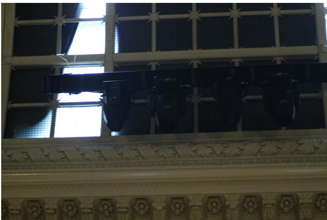
Figura 13 Treliças posicionadas na altura correta.
