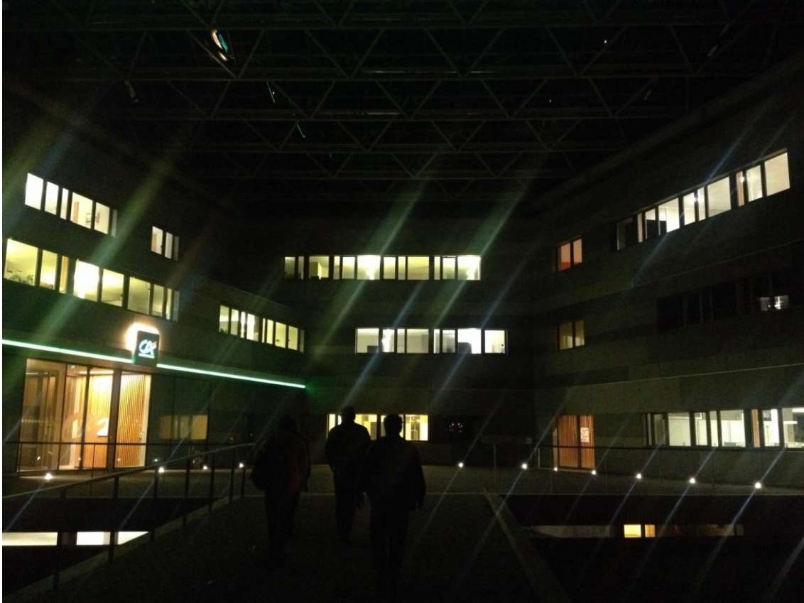
Figura 8 Vista interna do edifício.
