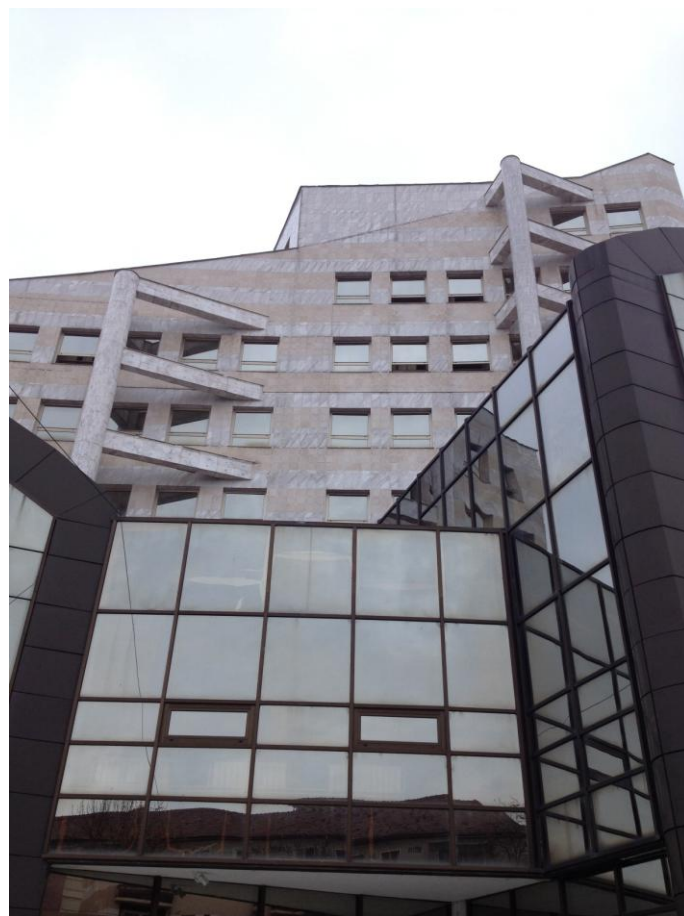
Figura 4 Vista externa do edifício em Sibiu.
