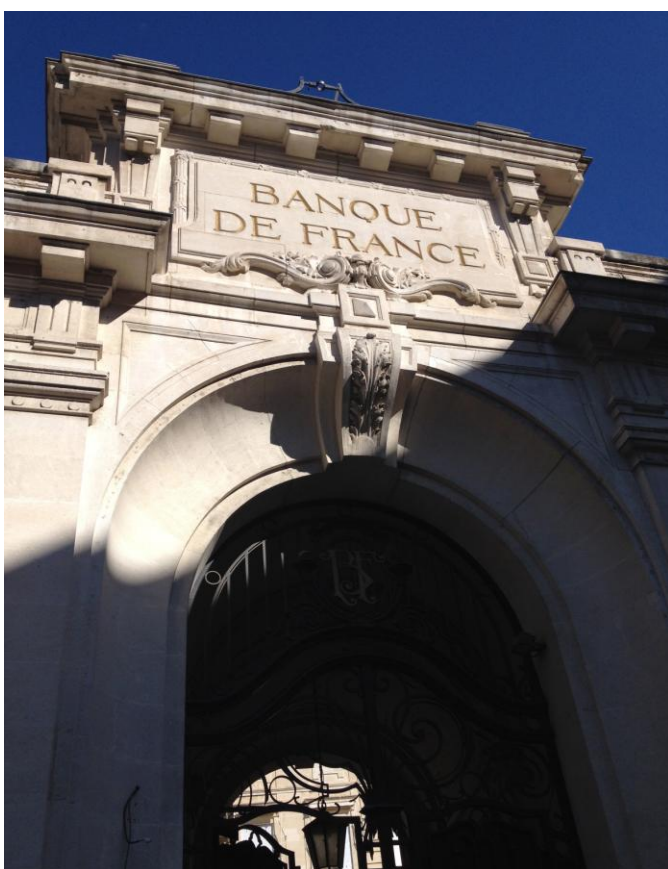
Figura 2 Fachada do Banc de France, em Avignon.
